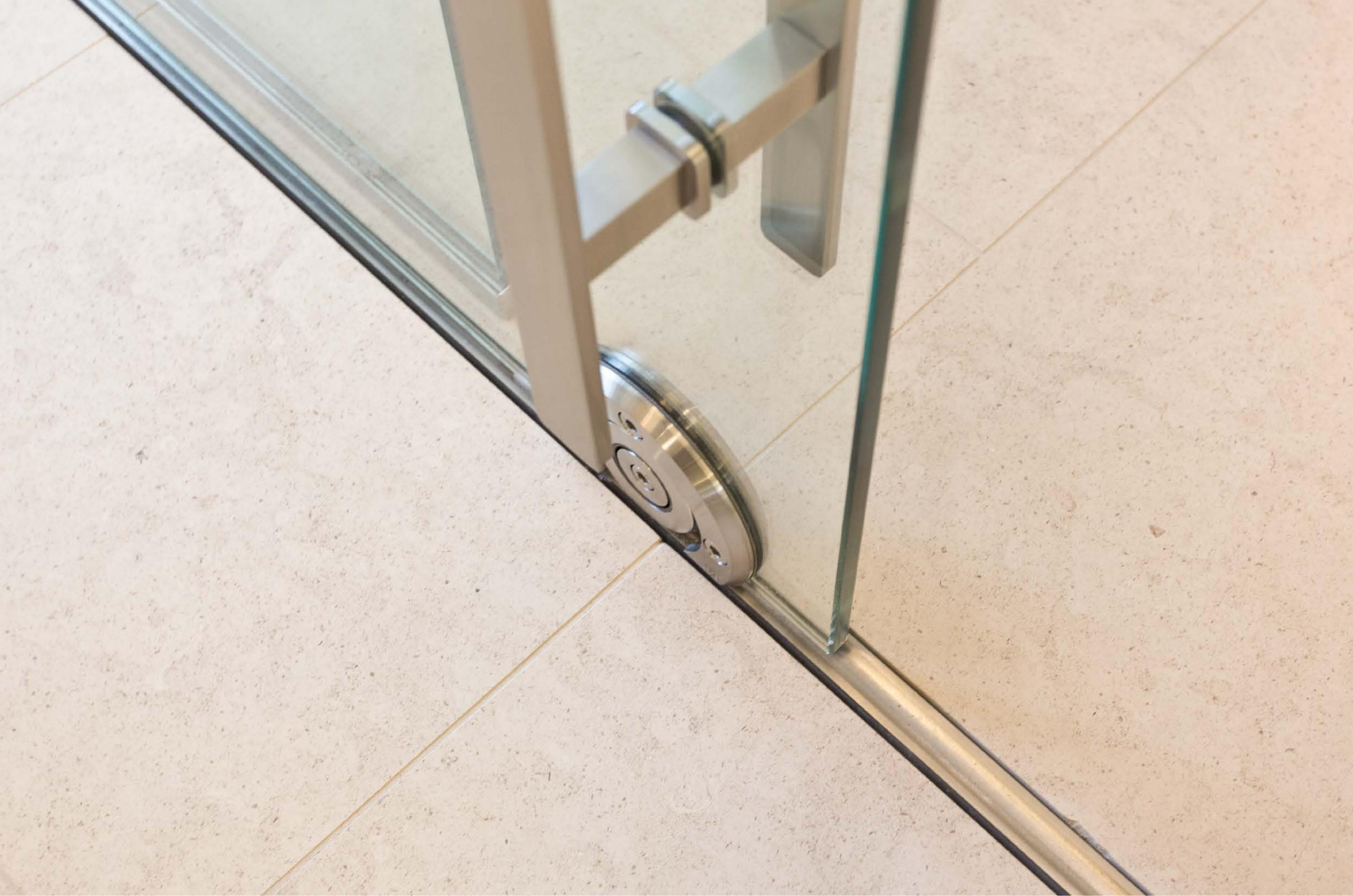
8 Schiebetür Terra M mit eingelassener Bodenlaufschiene
